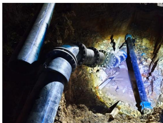
(d) Pipe Diversion bersaiz 350mm telah dipasang pihak kontraktor pembinaan jalan untuk menggantikan laluan paip asal bersaiz 350mm DI Pipe yang pecah.
