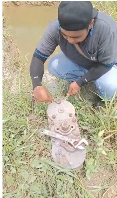
(b) Kerja -kerja pemeriksaan paip, injap dan lain – lain kelengkapan. Kerja menyelenggara DAV dan penggantian segera injap telah dilakukan.
