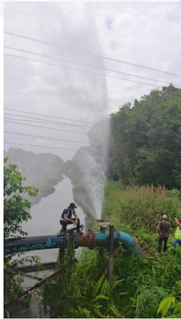
(a) Kerja Flushing di lakukan untuk membuang Air Lock di sepanjang jajaran paip dari Sri Aman ke Stumbin.
