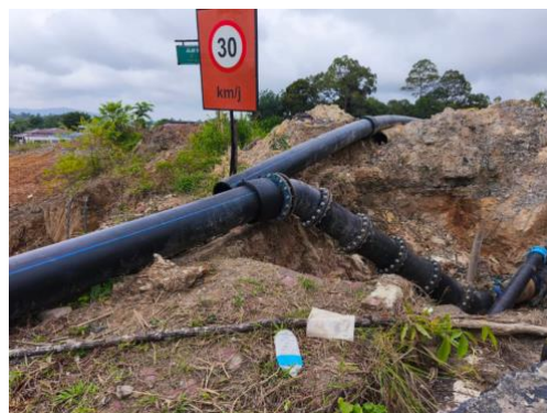
(c) Paip asal bersaiz 350mm DI Pipe yang pecah di dalam tapak pembinaan di Jalan Astana
