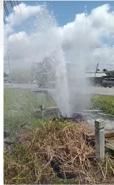
(a) Kerja Flushing di lakukan untuk membuang Air Lock di sepanjang jajaran paip dari Sri Aman ke Stumbin.
