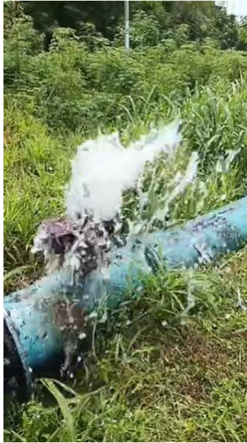
(a) Kerja Flushing di lakukan untuk membuang Air Lock di sepanjang jajaran paip dari Sri Aman ke Stumbin.
