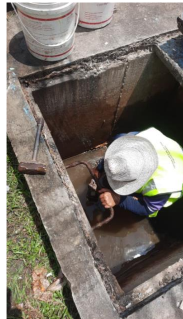
(b) Kerja -kerja pemeriksaan paip, injap dan lain – lain kelengkapan. Kerja menyelenggara DAV dan penggantian segera injap telah dilakukan.
