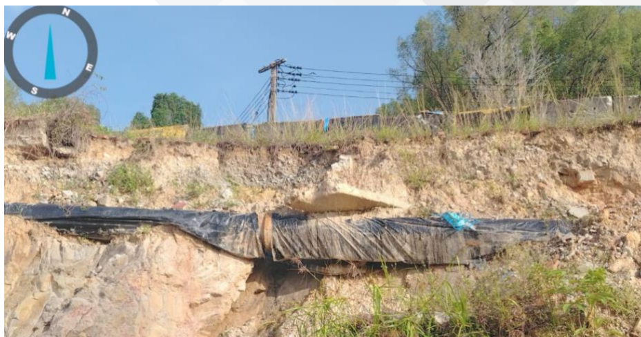
(c) Paip asal bersaiz 350mm DI Pipe yang pecah di dalam tapak pembinaan di Jalan Astana
