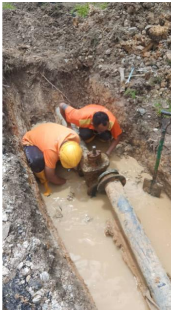
(b) Kerja -kerja pemeriksaan paip, injap dan lain – lain kelengkapan. Kerja menyelenggara DAV dan penggantian segera injap telah dilakukan.
